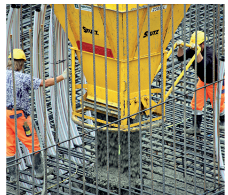
BETONARBEITEN AN DER BODENPLATTE
