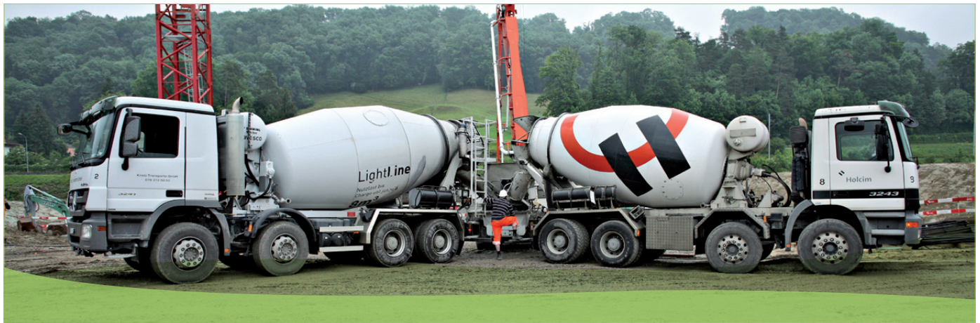
1'000 M 3 BETON FÜR DIE BETONPLATTE
